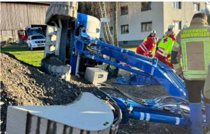
19. November · Hohenweiler Bagger umgekippt
