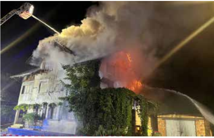
30. August · Lustenau Gebäudebrand
