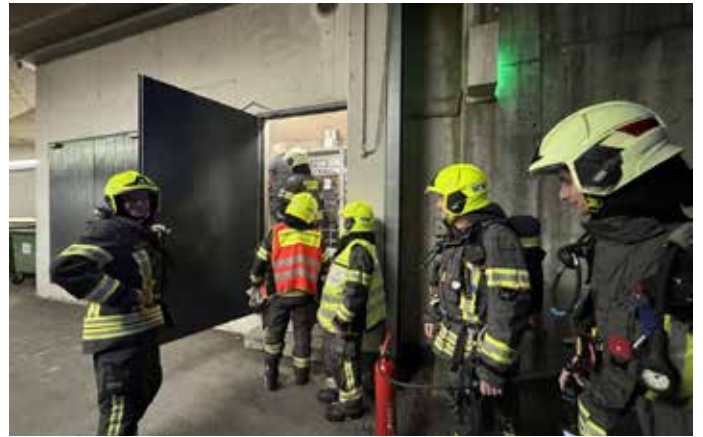
8. Februar · Schruns Trafobrand mit Stromausfall
