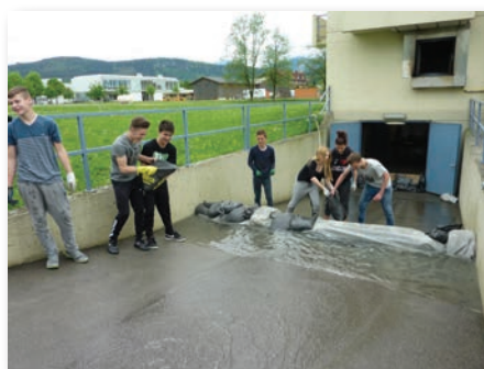
Objektschutz Hochwasser mittels einem fix installierten Dammbalkensystem
