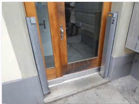
Objektschutz Hochwasser mittels einem fix installierten Dammbalkensystem
